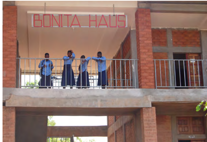
Alle Gebäude des BONITA-Hauses sind aus gepressten Lehmsteinen gebaut.
